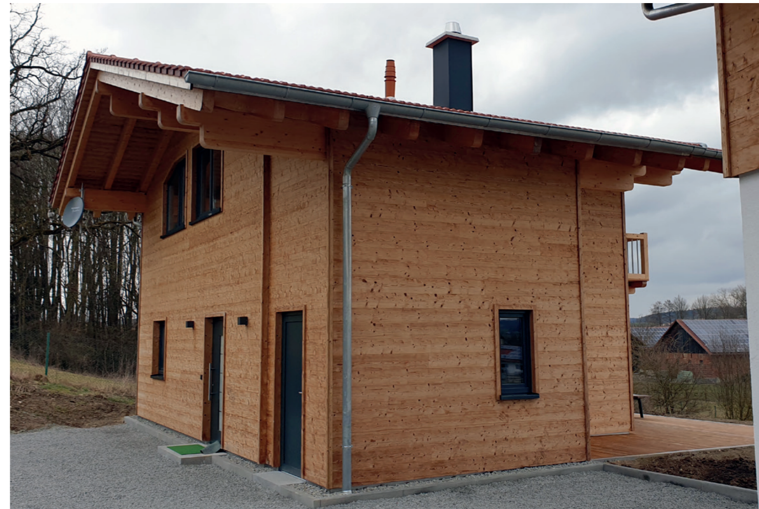
Holz als nachwachsender Roh-, Baustoff und CO 2 -Speicher
