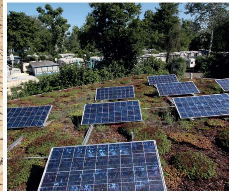
Links: Solare Bauweise (Sonnenschutz im Sommer und Solarwärme gewinnen im Winter) Oben: Biodiversität und passive Kühlung durch Dachbegrünung Unten: Solaranlagen und Dachbegrünung gehen gut zusammen
