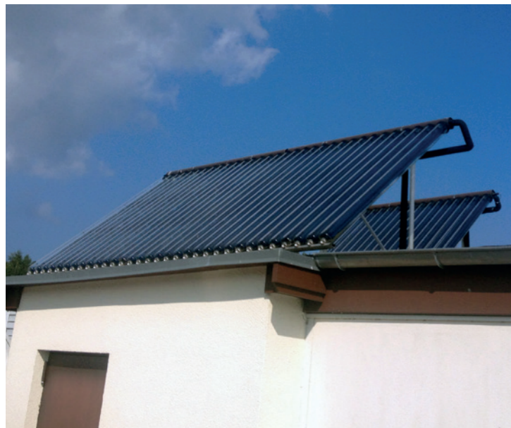
Vakuurröhren-Kollektoren
