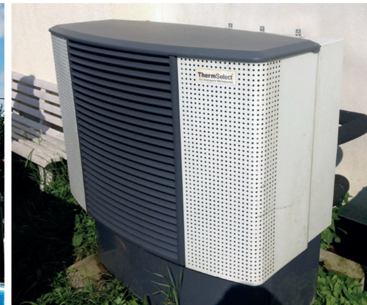
Absorber einer Luftwärmepumpe
