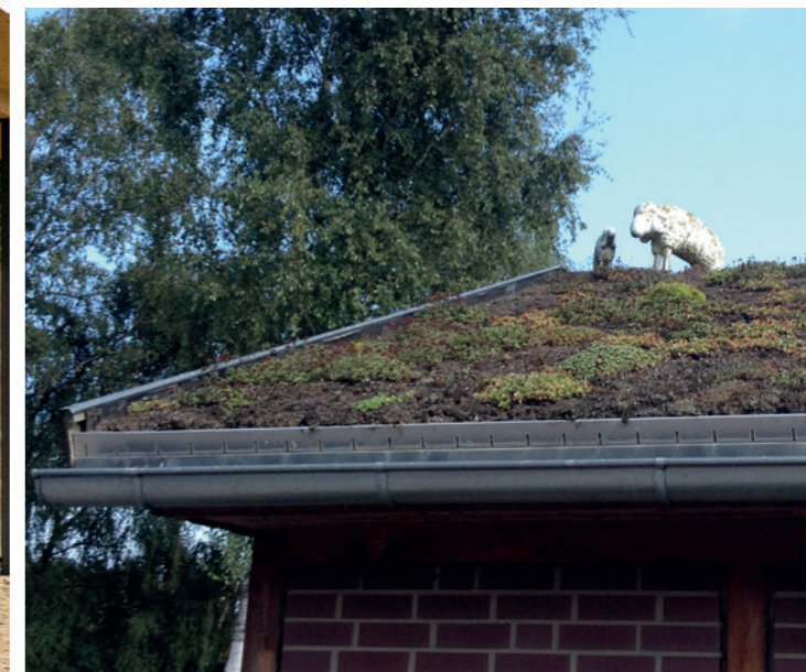
Links: Solare Bauweise (Sonnenschutz im Sommer und Solarwärme gewinnen im Winter) Oben: Biodiversität und passive Kühlung durch Dachbegrünung Unten: Solaranlagen und Dachbegrünung gehen gut zusammen
