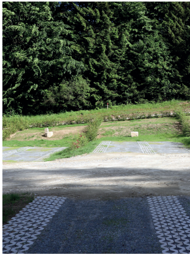
Rechts und links: Standplatz- und Wegebefestigung, ohne zu versiegeln, mit Rasengittersteinen und Schotter (Stellplatz Camping Resort Bayerwald) Unten: Biodiversität und Bodenaufbau
