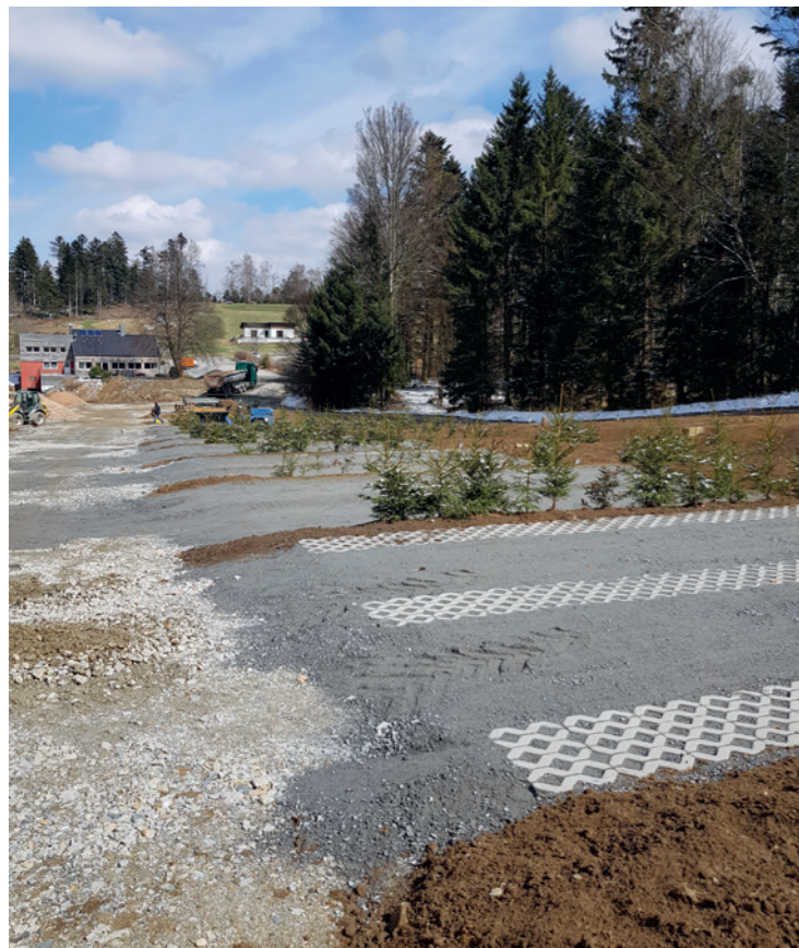
Rechts und links: Standplatz- und Wegebefestigung, ohne zu versiegeln, mit Rasengittersteinen und Schotter (Stellplatz Camping Resort Bayerwald) Unten: Biodiversität und Bodenaufbau
