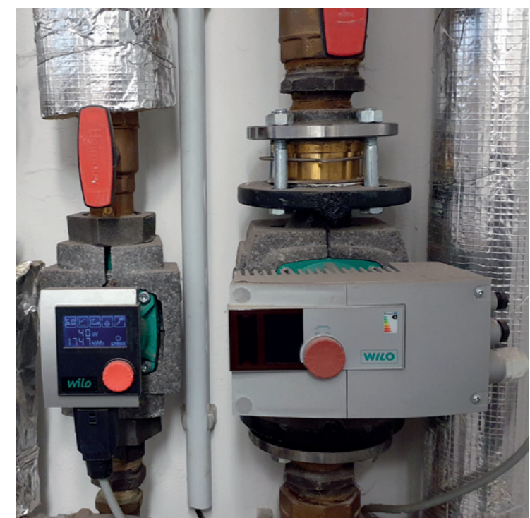
Oben: Planungsgespräch auf dem Camping Resort Bayerwald Mitte: Ötters mal abschalten und Energie sparen Unten: Geregelt Pumpen sparen Strom
